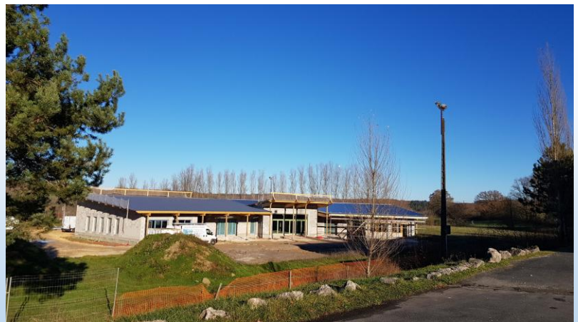
Avancement des travaux au 20 décembre 2024
