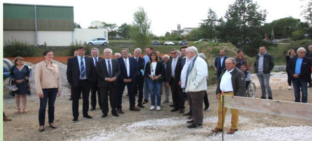
Ecole intercommunale du tournonnais. Pose de la première pierre pour une ouverture à la rentrée scolaire 2025.
